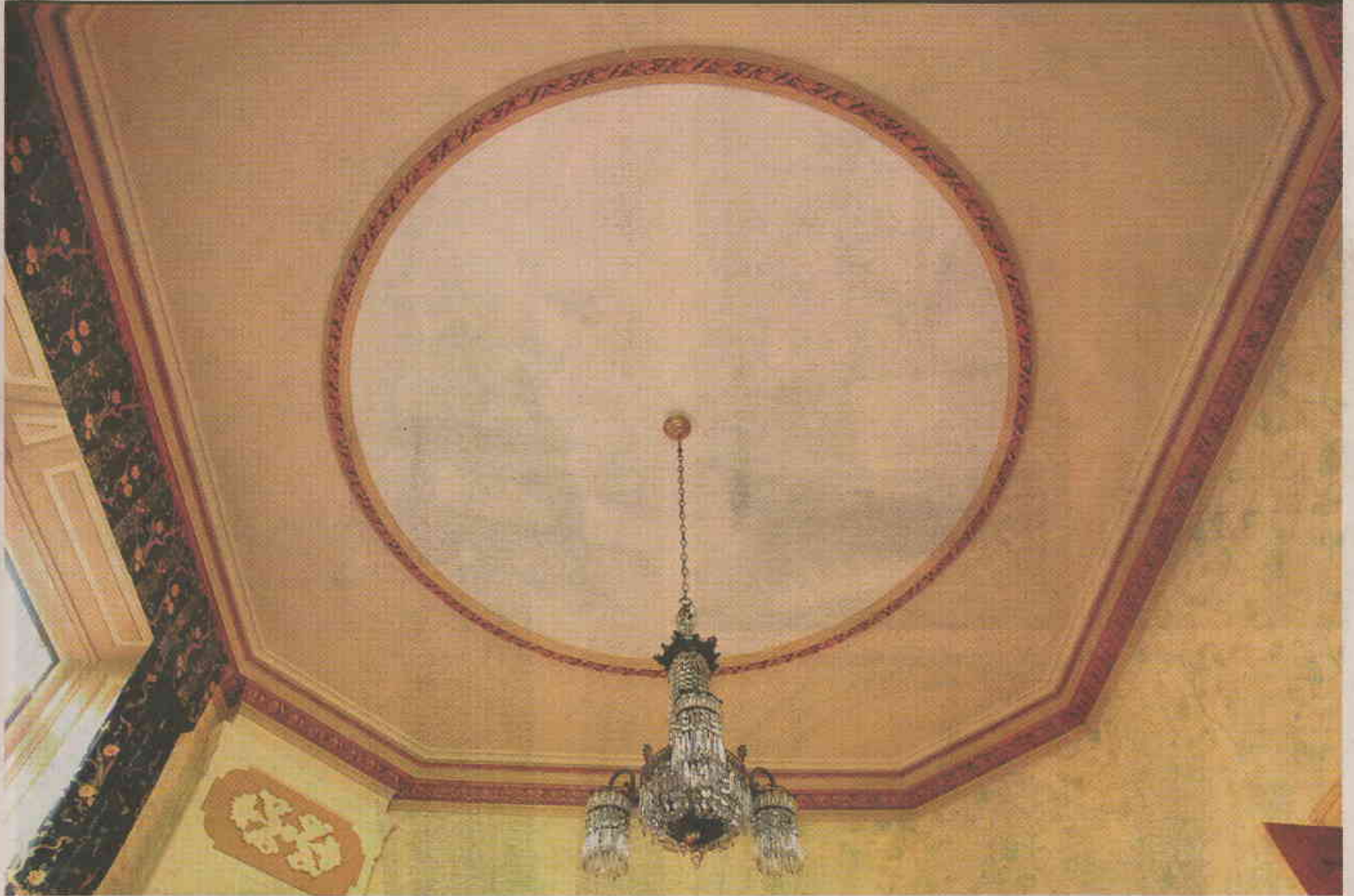
Foto links: De gerenoveerde salonkamer. Het parket op de vloer is afkomstig van hout uit Franse treinwagons. Foto boven: Het plafond is weer helemaal in ere hersteld. Louise maakte voor de decoratie een mal en tig afdrucken van gips.
